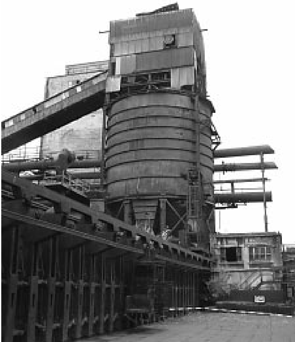
Bild 1: Gesamtansicht alter Kohlenturm
