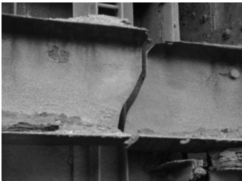
Bild 19: Riß in umlaufenden U-Band
