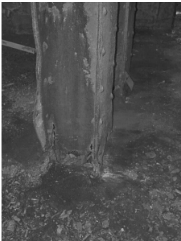
Bild 12: Stütze II, nach Begutachtung, Außenseite
