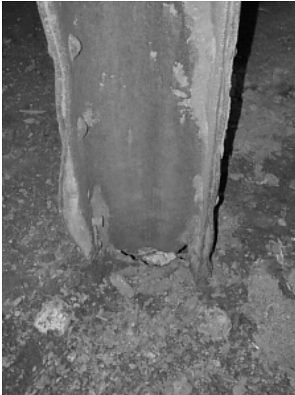
Bild 10: Stütze II, Ausgangszustand, Außenseite
