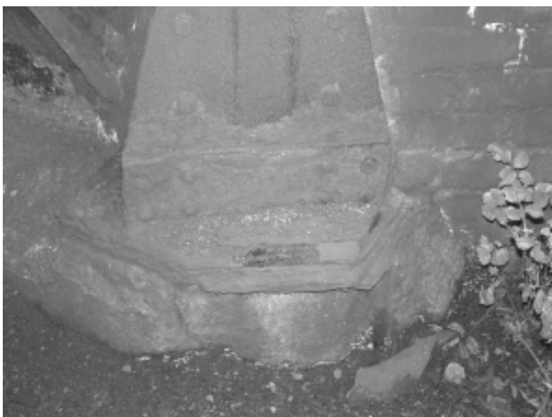
Bild 21: Fuß der Aufständering
