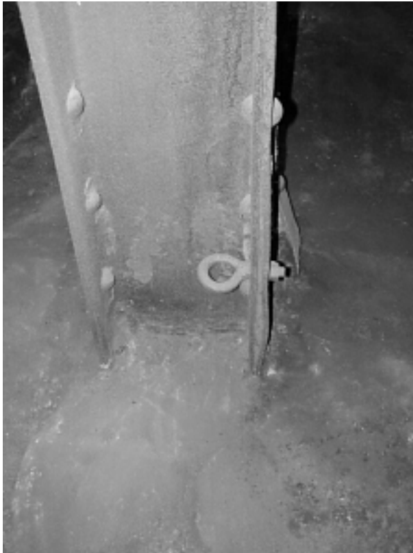
Bild 8: Stütze I, nach Begutachtung, Innenseite
