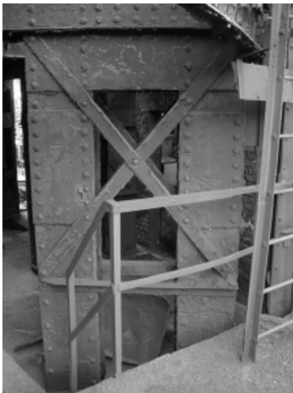
Bild 5: Oberes Kreuz zwischen den Kästen A und B der Stütze X
