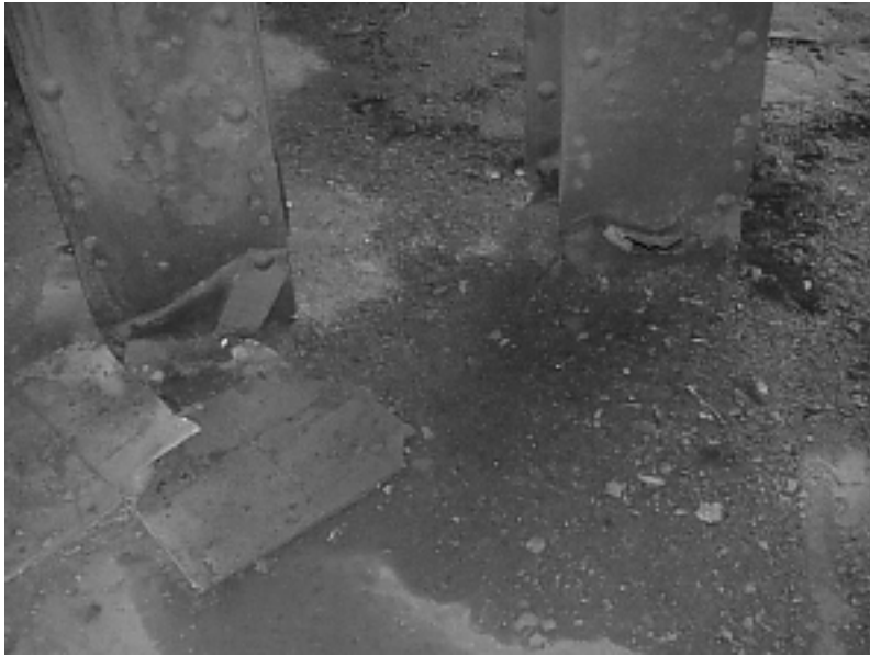
Bild 6: Stütze I, Ausgangszustand, links
