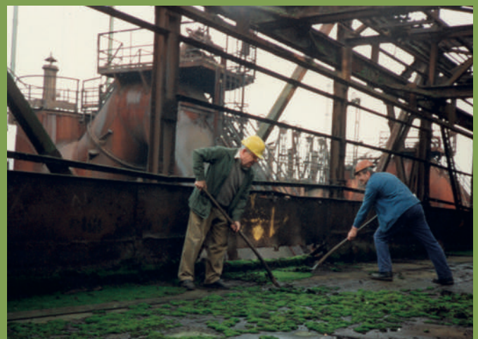
Reinigung der Kranbahn auf der Abstichebene (1993)
