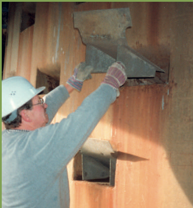
Reinigung und Sichtung der Rieselkästen am Hochofen 6 (1993)
