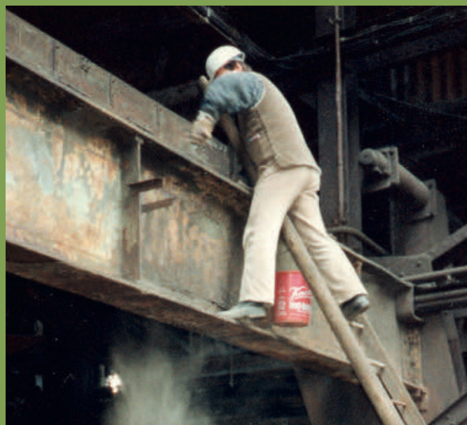
Reinigung der Gichtbühne im Bereich Hochofen 6 (1993)
